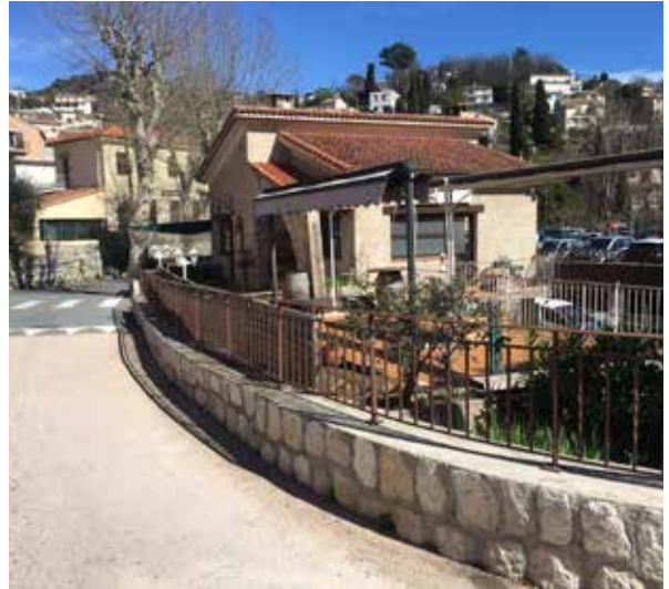
Ici, des travaux de sécurisation vont être réalisés.
