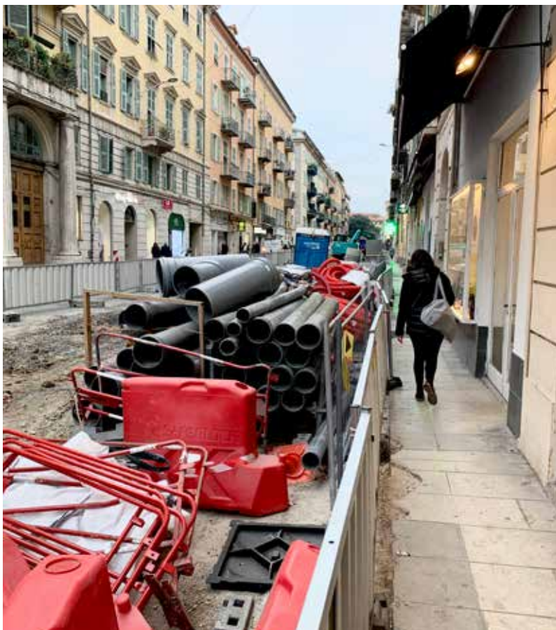
À Nice, le remplacement de canalisations dans le quartier du port. (Ph. M.B.)
